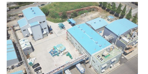
PO3G 생산설비 건설 중
